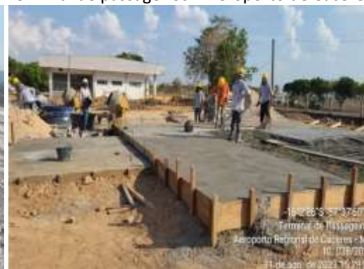
Terminal de passageiros – Aeroporto de Cáceres/MT
