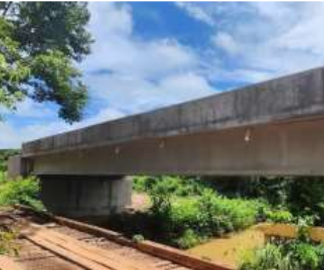
Ponte sobre o córrego São Joaquim
