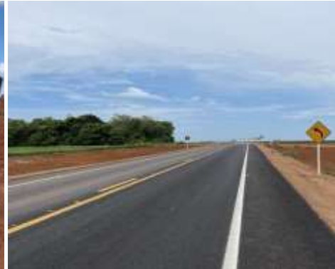
Pavimentação Rodovia MT-010
