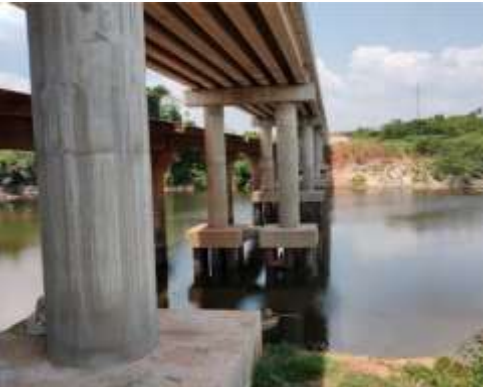
Ponte sobre o Rio Apiacás
