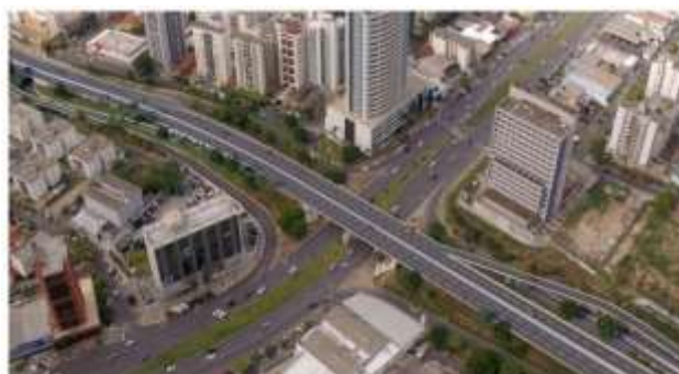
Adequação Viária Viaduto Av. do CPA / Miguel Sutil - Cuiabá
