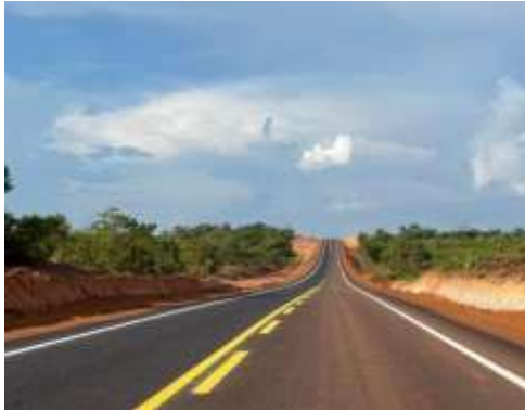
Pavimentação Rodovia MT-129
