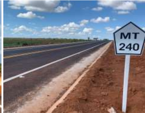
Pavimentação Rodovia MT-240
