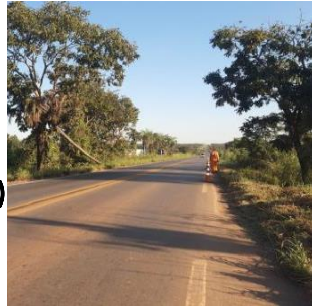
Manutenção de Rodovia Pavimentada (MT-010)
