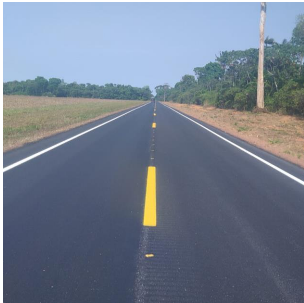
Restauração Rodovia MT-423 (I.C. 053/2022)
