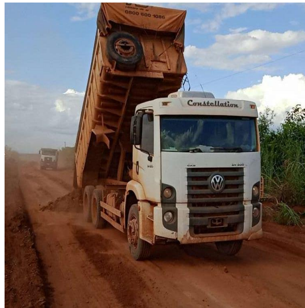
Manutenção de Rodovia Não Pavimentada (MT-130)
