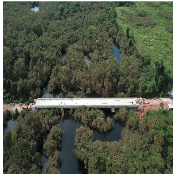
Ponte sobre o Rio Batelão II (PT00664)
