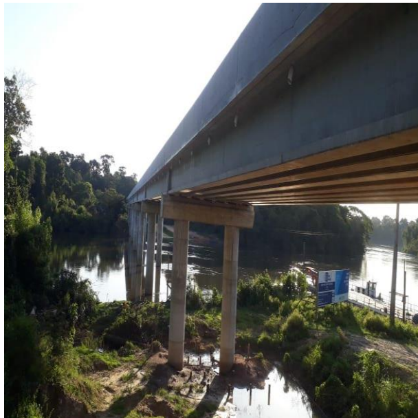
Ponte sobre o Rio Apiacás (PT02444)
