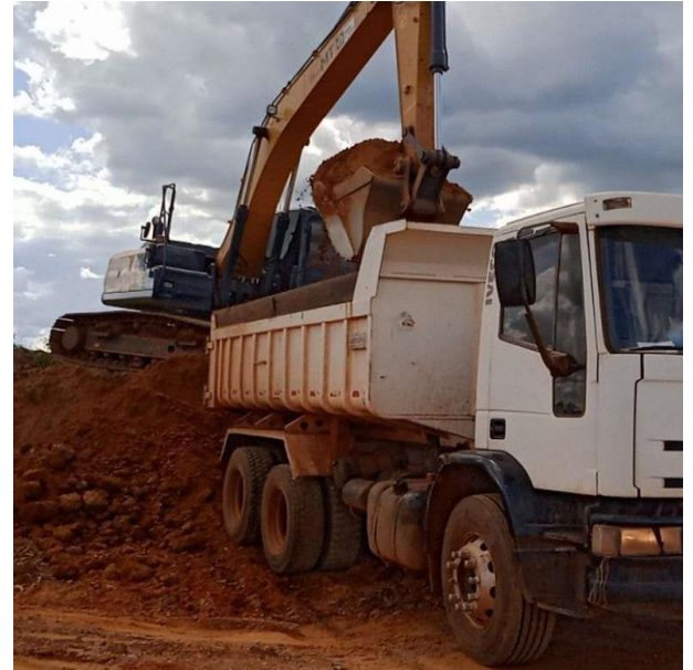
Manutenção de Rodovia Não Pavimentada (MT-020)
