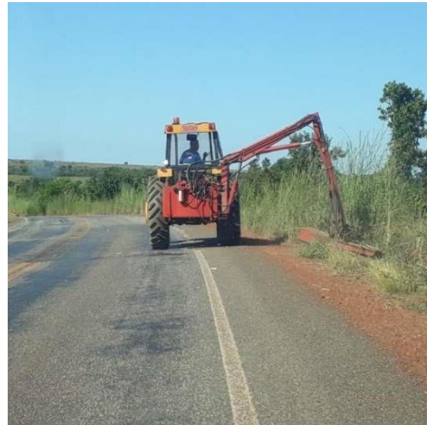
Manutenção de Rodovia Pavimentada (MT-020)
