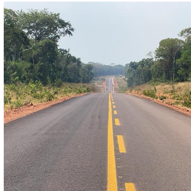
Pavimentação Rodovia MT-220 (I.C. 016/2021)
