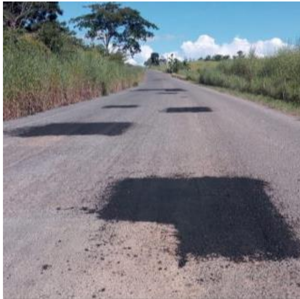
Manutenção de Rodovia Pavimentada (MT-494)
