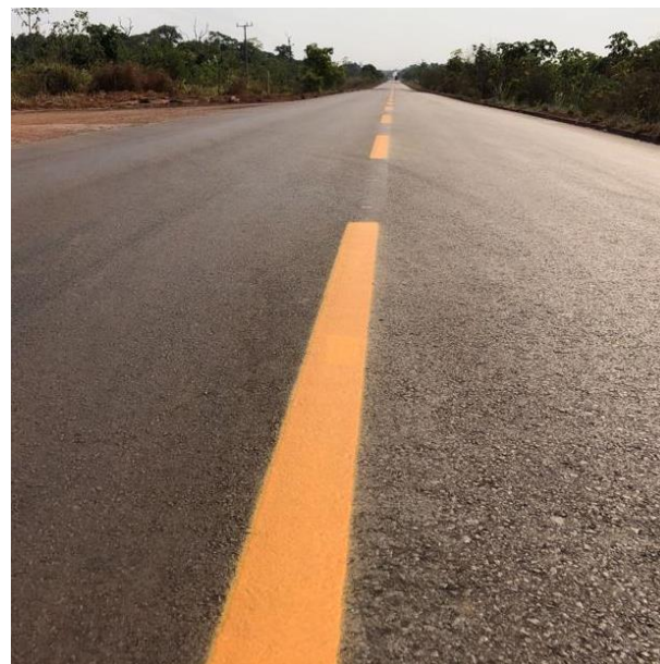
Restauração Rodovia MT-430/437 (I.C. 105/2021)
