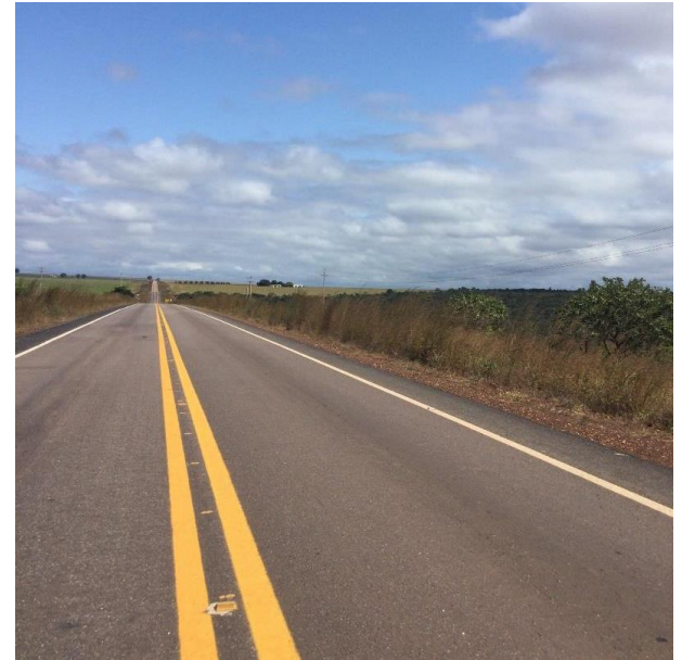
Pavimentação Rodovia MT-140 (I.C. 001/2008)
