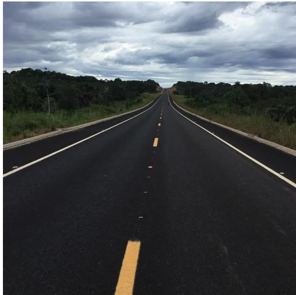
Pavimentação Rodovia MT-100 (I.C. 041/2020)
