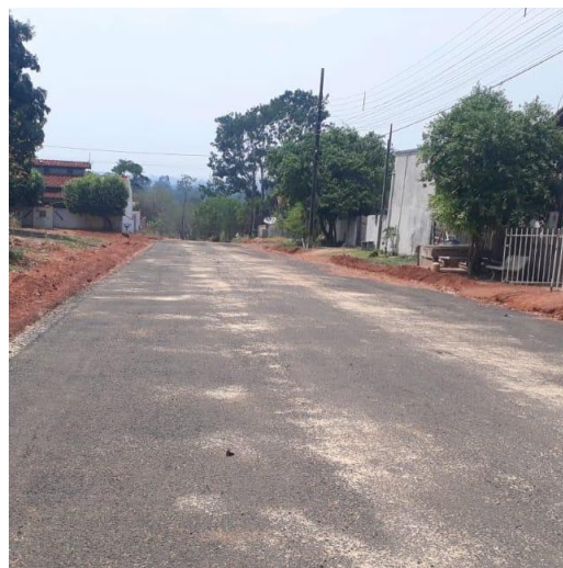
PAVIMENTAÇÃO DA RUA CAXIAS JUARA
