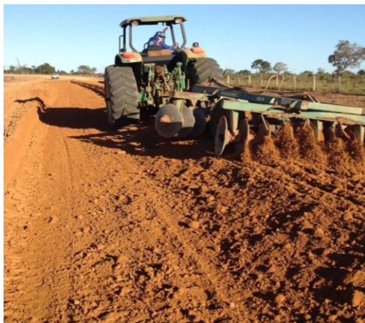
PAVIMENTAÇÃO DA RODOVIA MT-322 NOVO SANTO ANTÔNIO
