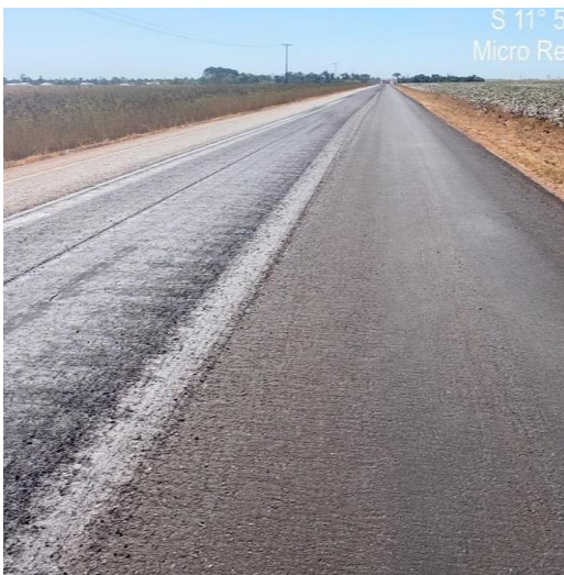
MANUTENÇÃO NA RODOVIA MT-222 – REGIÃO 5
