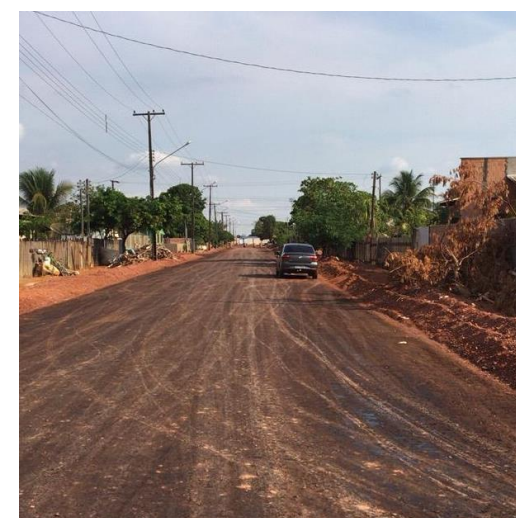
PAVIMENTAÇÃO DA RUA PERU VERA
