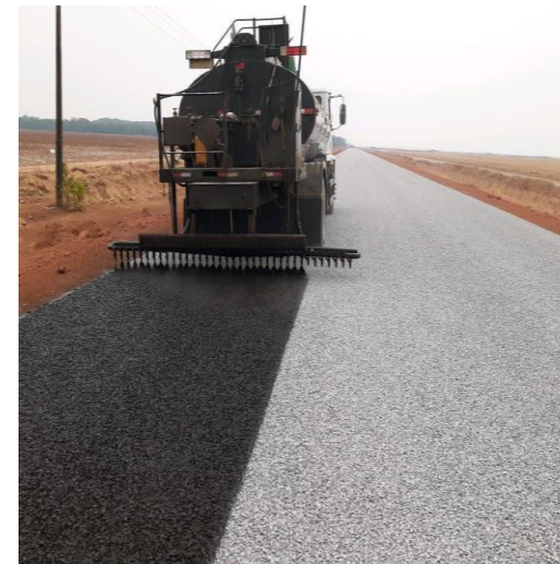
PAVIMENTAÇÃO DA RODOVIA MT-010 IPIRANGA DO NORTE
