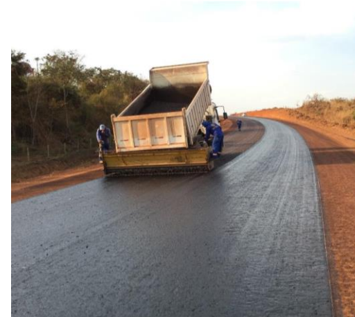
PAVIMENTAÇÃO DA RODOVIA MT-110 NOVO SÃO JOAQUIM
