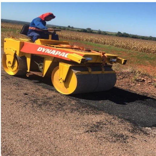
MANUTENÇÃO NA RODOVIA MT-225 – REGIÃO 5
