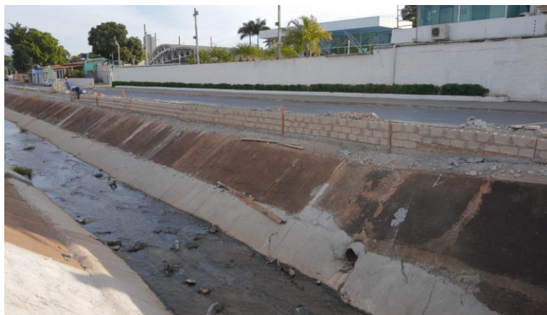
Execução de muro de arrimo
