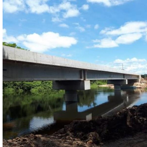
PONTE SOBRE O RIO CASSANGE - RODOVIA MT-060
