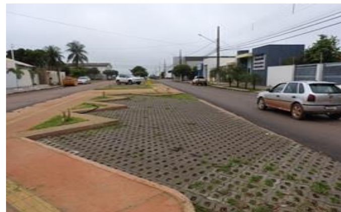
Revitalização de Canteiro Central com Estacionamento da Avenida do Colonizador Roque Guedes no Município de Colíder
