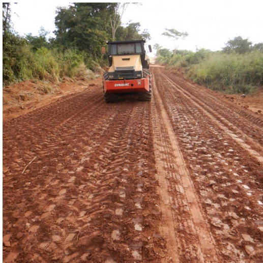
MANUTENÇÃO NA RODOVIA MT 352 - REGIÃO 2
