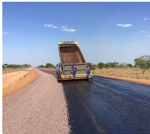
PAVIMENTAÇÃO DA RODOVIA MT-322 NOVO SANTO ANTÔNIO
