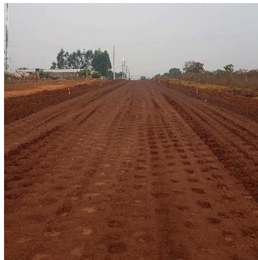
PAVIMENTAÇÃO DA AV. DELSON RODRIGUES GENERAL CARNEIRO
