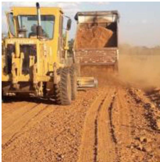
MANUTENÇÃO NA RODOVIA MT 476 - REGIÃO 1
