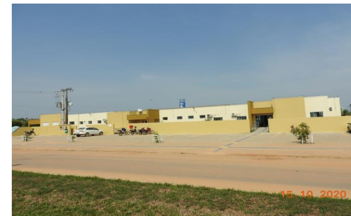
Ampliação e Reforma do Hospital de Apiaçás
