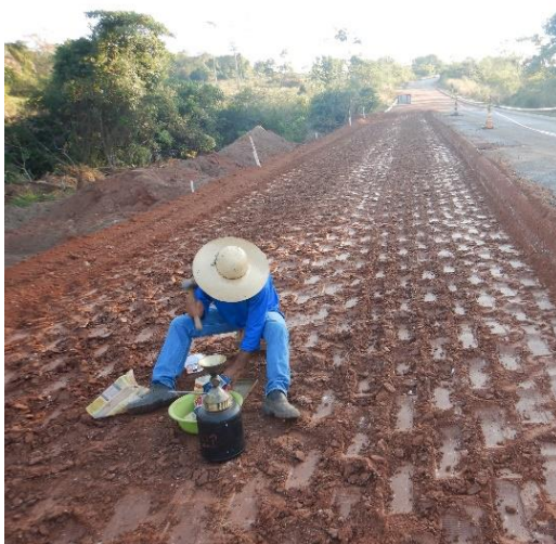
MANUTENÇÃO NA RODOVIA MT 248 - REGIÃO 2
