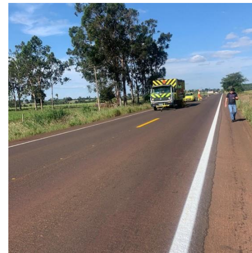
RESTAURAÇÃO DA RODOVIA MT-358 TANGARÁ DA SERRA
