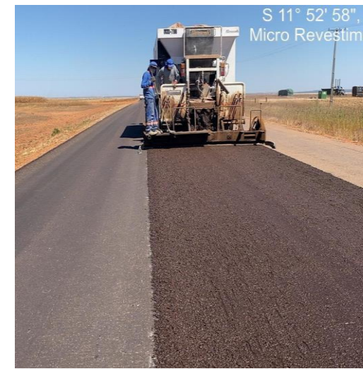
MANUTENÇÃO NA RODOVIA MT-222 – REGIÃO 5
