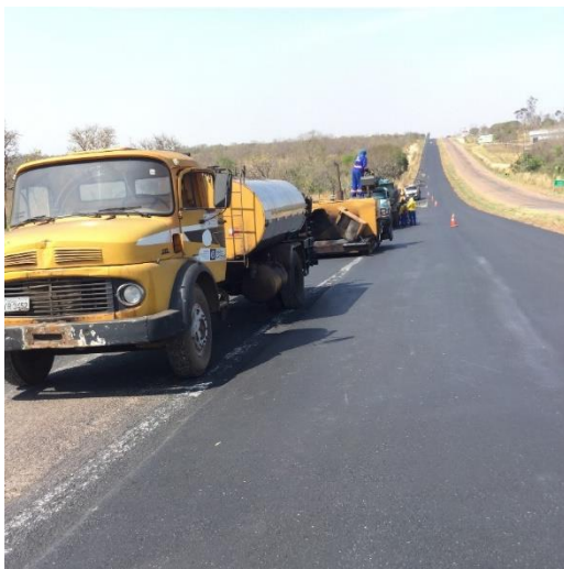
RESTAURAÇÃO DA RODOVIA MT-020/251 CUIABÁ
