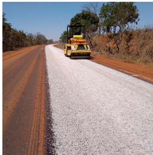
RESTAURAÇÃO DA RODOVIA MT-270 RONDONÓPOLIS
