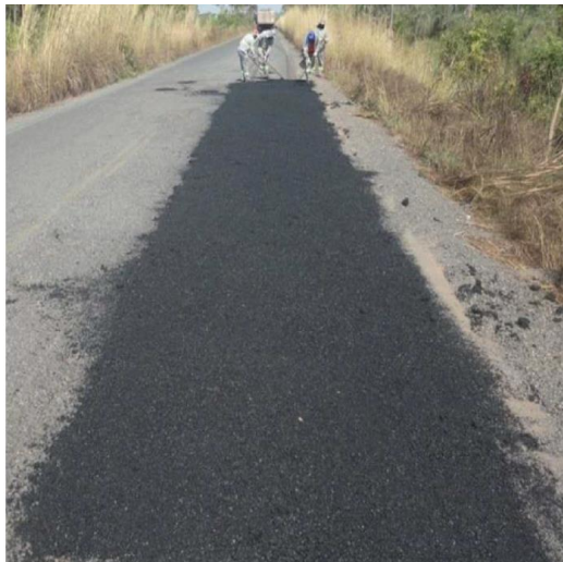
MANUTENÇÃO NA RODOVIA MT-040 – REGIÃO 1
