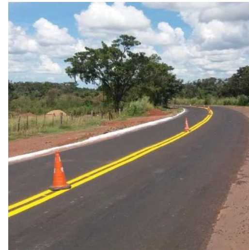
MANUTENÇÃO NAS RODOVIA MT 246/343/358/339
