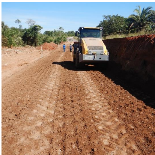
MANUTENÇÃO NA RODOVIA MT 248 - REGIÃO 2
