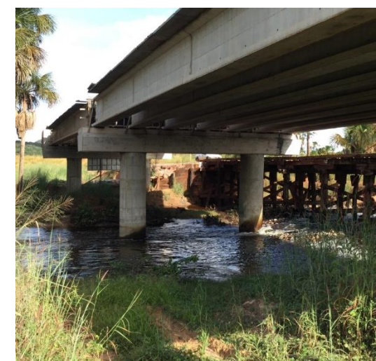
PONTE SOBRE O ÁGUA PRETA – RODOVIA MT-326
