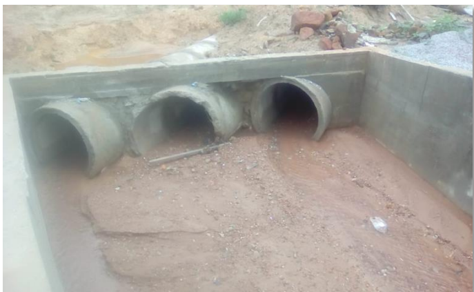
Drenagem de águas pluviais no município de Peixoto de Azevedo
