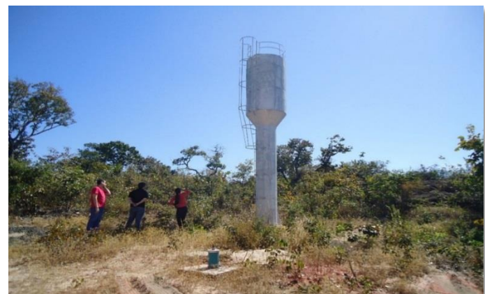
Poço tubular profundo na agrovila paraíso no município de Araguainha
