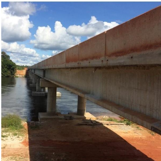
PONTE SOBRE O RIO SANGUE - RODOVIA MT-242
