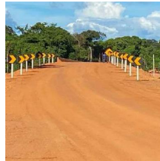
MANUTENÇÃO NA RODOVIA MT 488 - REGIÃO 06
