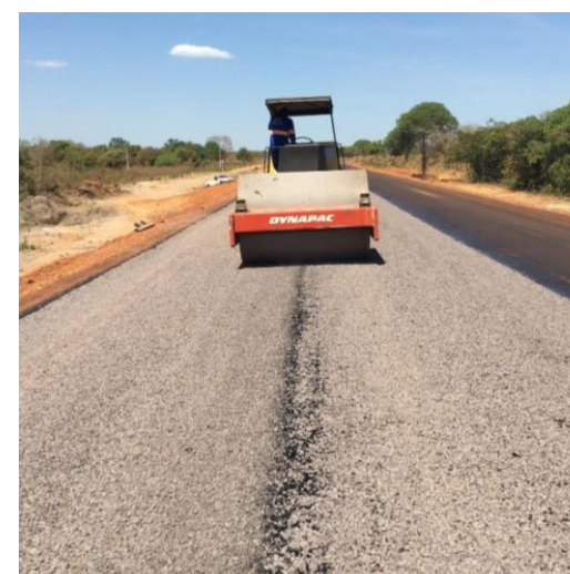
PAVIMENTAÇÃO DA RODOVIA MT-326 COCALINHO
