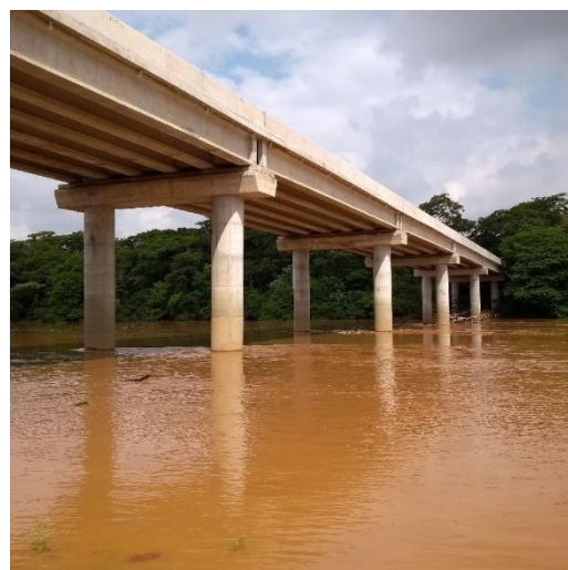
PONTE SOBRE O RIO VERMELHO - AV.W11
