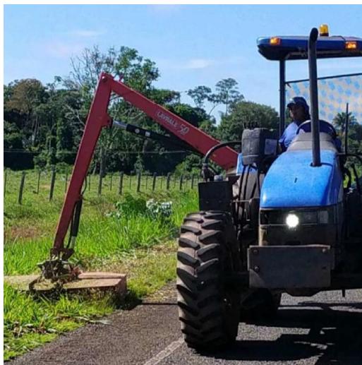
MANUTENÇÃO NA RODOVIA MT-170 – REGIÃO 3
