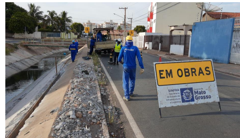
Demolição de concreto simples
