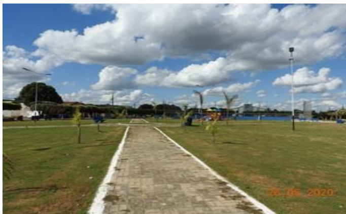
Construção de um praça no Jardim Vitória no Município de Guarantã do Norte
