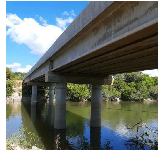
PONTE SOBRE O RIO TAPAIUNA - RODOVIA MT-010
