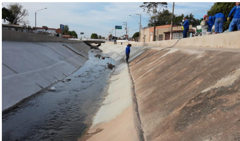
Execução de argamassa projetada
