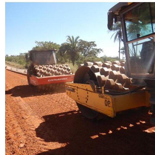
MANUTENÇÃO NA RODOVIA MT 248 - REGIÃO 02
