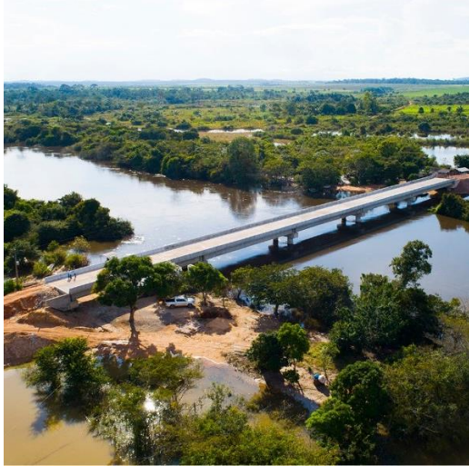
PONTE SOBRE O RIO BRAÇO NORTE II - RODOVIA MT-322
