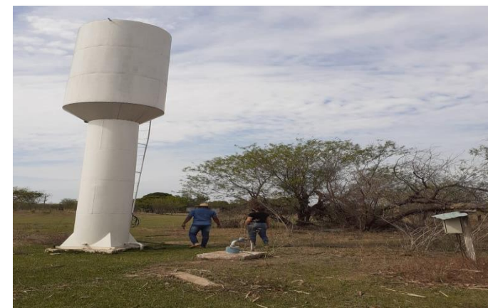
Perfuração de 08 poços no município de Denise
