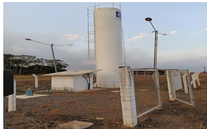
Perfuração e implantação de poços nos municípios de Comodoro, Nova Lacerda e Conquista d'Oeste - Lote 02
