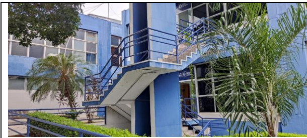
Lateral direita da escada posterior
